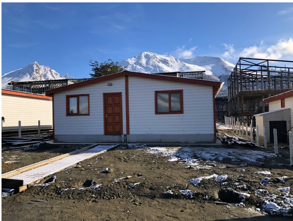
Foto 2 - Implantación, fijación y ensamble de 8 módulos. Mzo 162, URP, Ushuaia. Empresa: Sica Río Grande S.R.L. FONAVI
